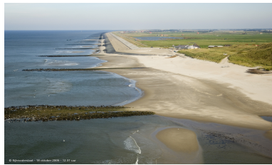
(a) Sea-dyke Hondsbossche Zeewering (area 1).
