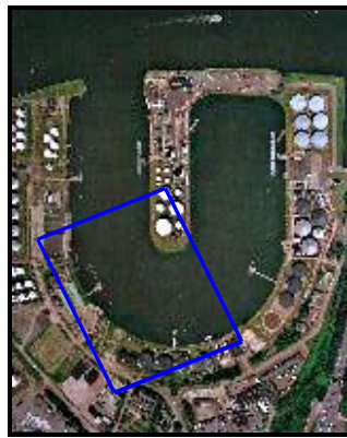
Figuur 5.1: Een luchtfoto van de Petroleumhaven in Amsterdam
